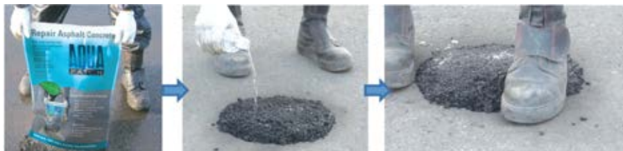
Рисунок 3. Технологическая последовательность устройства патча (заплаточного материала)
