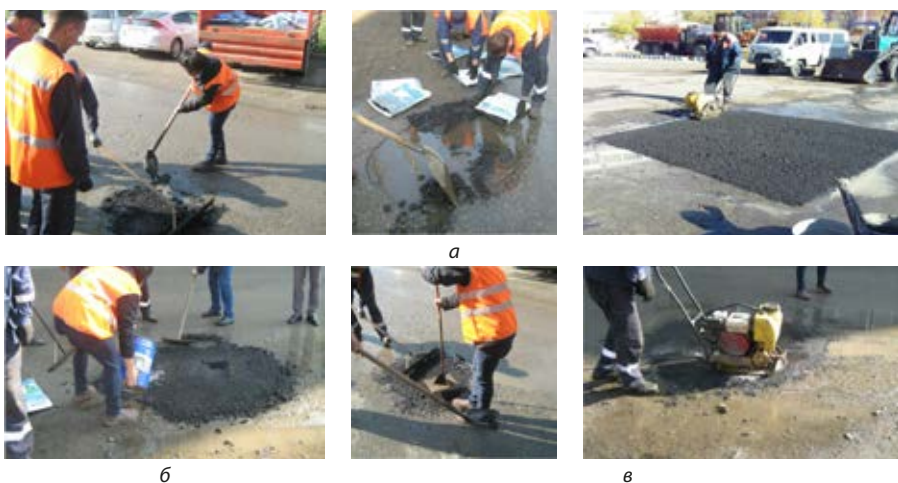
Рисунок 5. Результаты опытной укладки смеси «АКВАПАТЧ» в ходе заделки выбоины: а) заделка места дефекта (выбоины) асфальтобетонного покрытия ремонтной смесью; б) заливка водой места укладки; в) уплотнение смеси.
